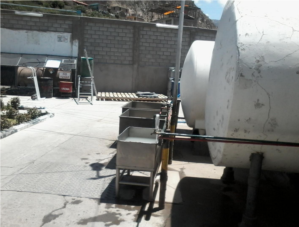
1 Planta de enfriamiento de Leche Gloria en Puquina
